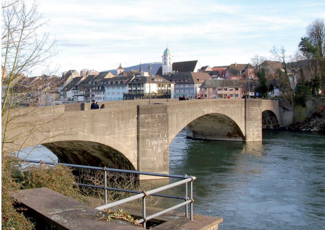
Rheinbrücke in Rheinfelden, 1912, Bogenbrücke aus Stahlbeton, Hauptspannweite 40 m
